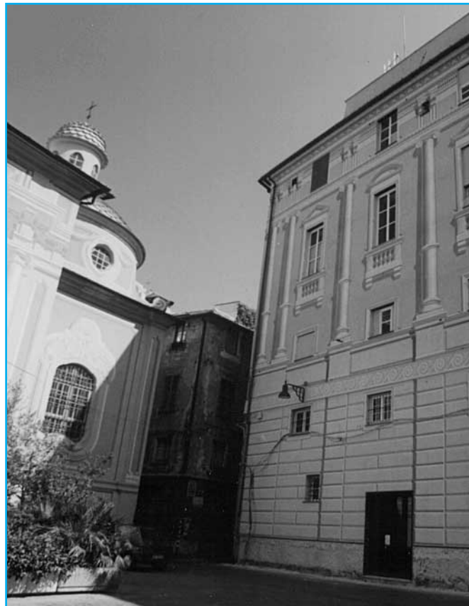
Palazzo Della Rovere, fatto costruire da Giulio II
