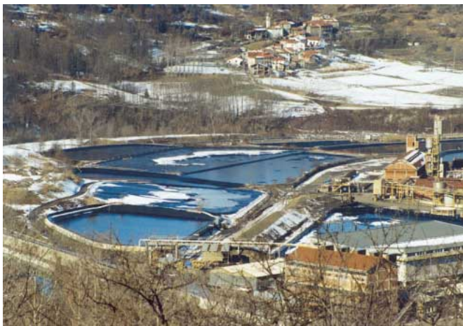
Una veduta dell'Acna e, sopra, un particolare dei gradi "lagoons" che dovranno essere bonificati. Tutti i rifiuti speciali saranno essiccati e inviati per lo smaltimento in una vecchia miniera dell'ex Germania Est.
